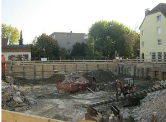
Foto 39: Baustelle am Stadttor
