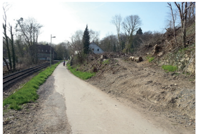
Abb. 25: Weg süd-östlich des Blauen Sees: Bsp: schlechter Wegezustand
