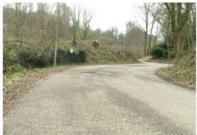
Abb. 31: Asphaltierte Straße in gutem Zustand
