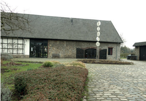
Abb. 4: Burghof Wasserburg Haus zum Haus
