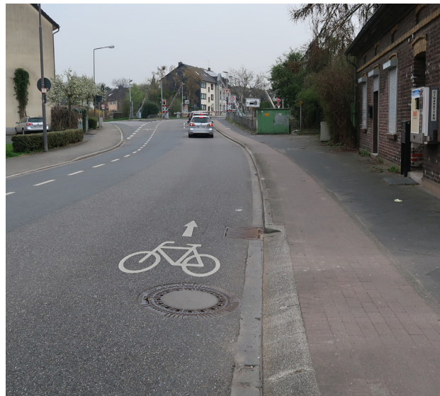
Abb. 49: Radweg und -markierung an der Rosenstraße
