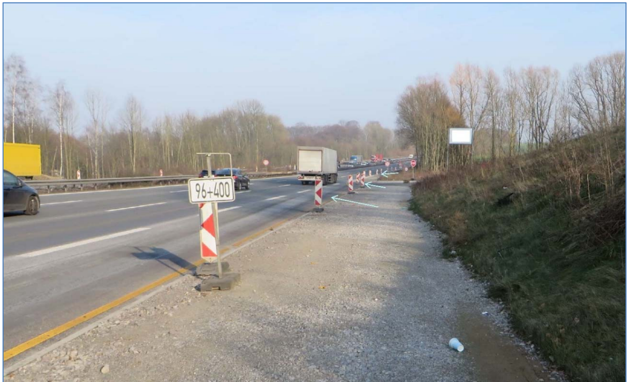
Die A3 FR Oberhausen im Tiefpunkt neben der bestehenden SAL (rechts hinter dem Damm). Hier wird bei Starkregen durch Überstau aus der Kanalisation austretendes Wasser Teile beider Fahrbahnseiten überfluten (blaue Pfeile).
