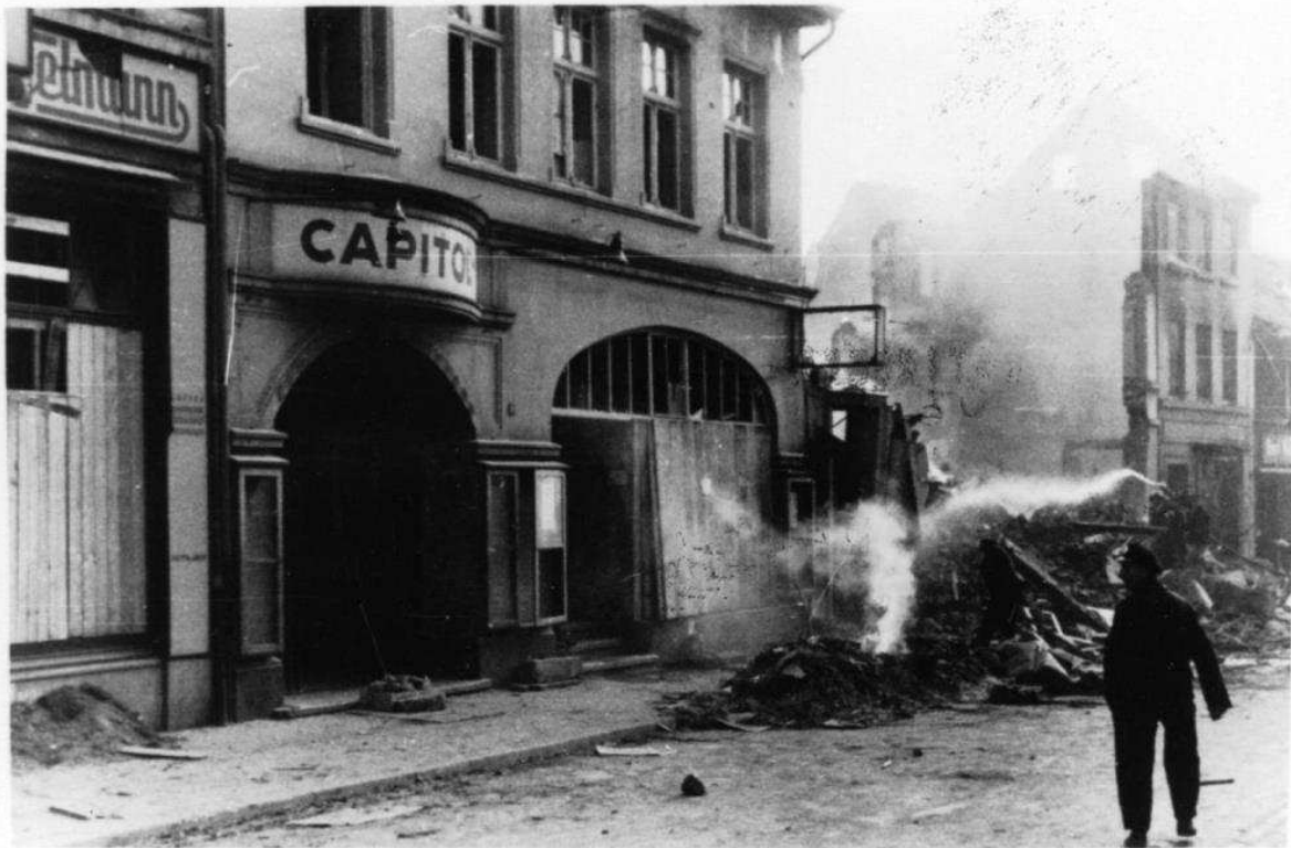
Oberstraße Nr. 10, Höhdorf – Capitolkino, Nr. 4 und 6 noch brennend
