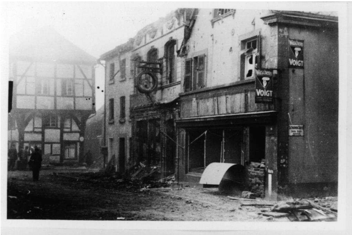
Oberstraße Nr. 27 und 29 zerstört, im Hintergrund die heutigen Suitbertusstuben
