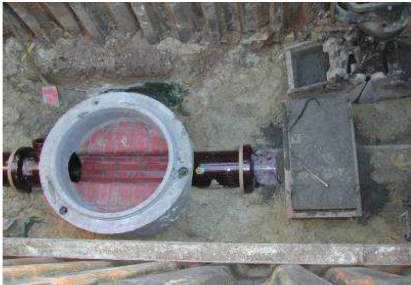
Neubau im offenen Graben
